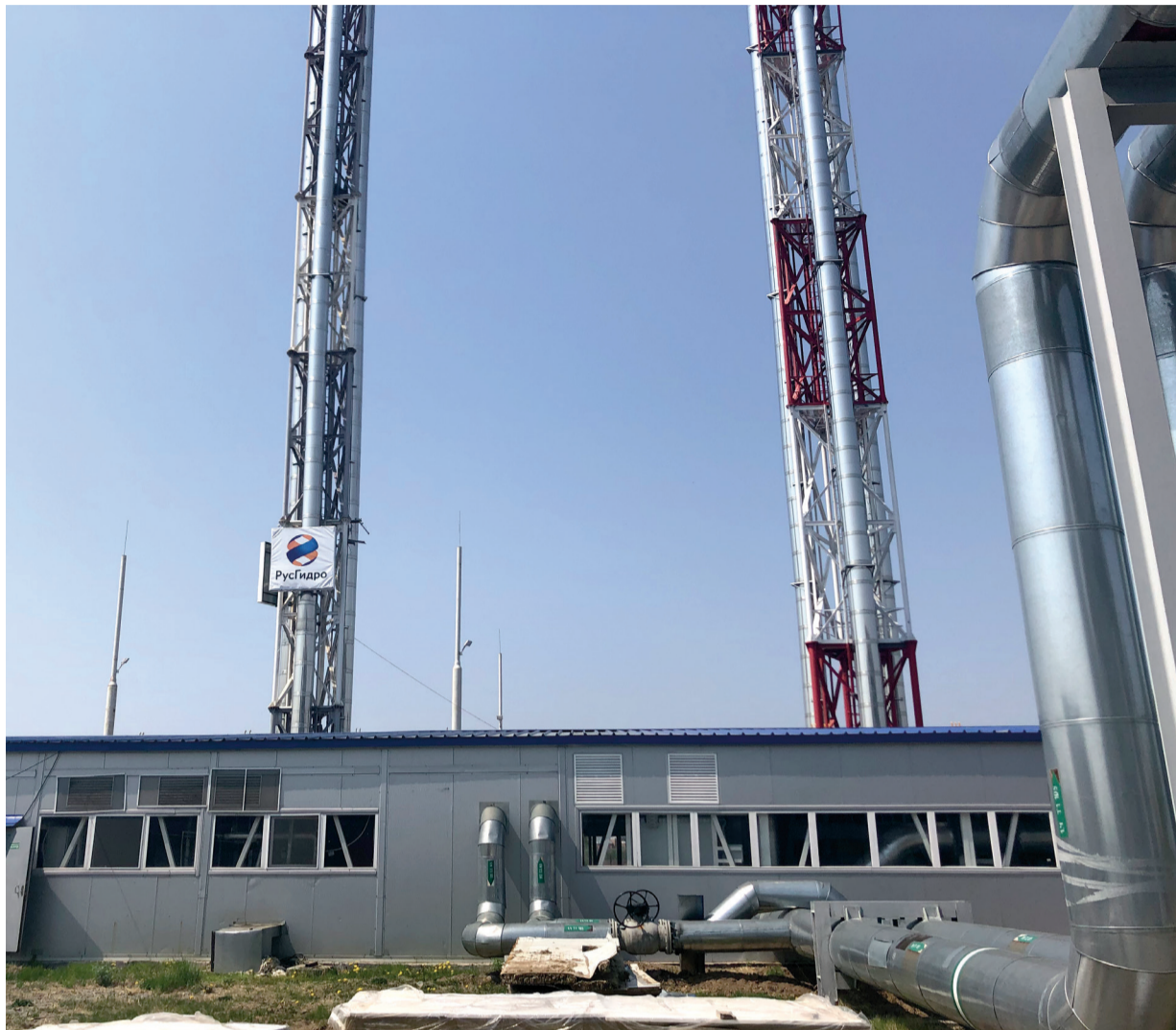
Строительство второй очереди Волочаевской котельной - один из объектов инвестпрограммы ДГК.
