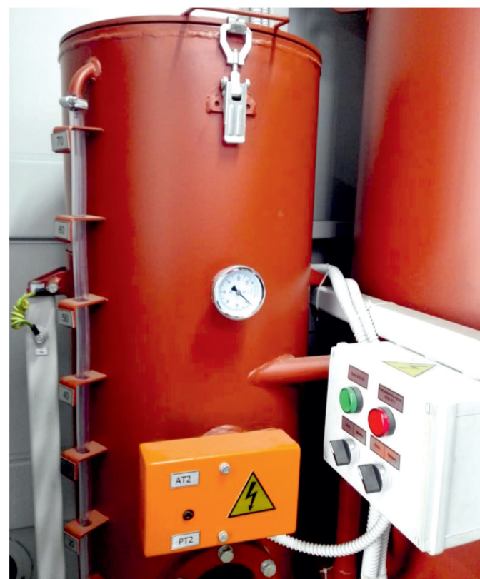
Баки очистки масла новой установки.
