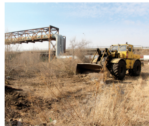
Тяжелая техника уже расчистила будущую площадку строительства.
