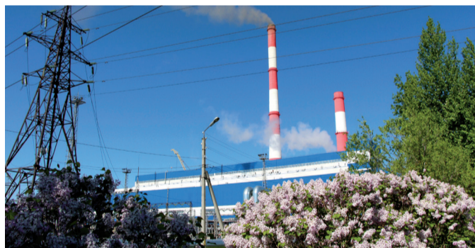
Благовещенская ТЭЦ прошла весенние испытания теплосетей.
