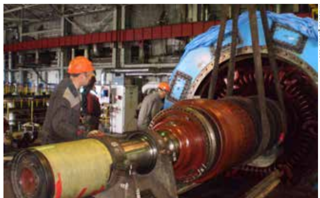
Энергетики выводят ротор генератора из статора для дальнейшего ремонта
