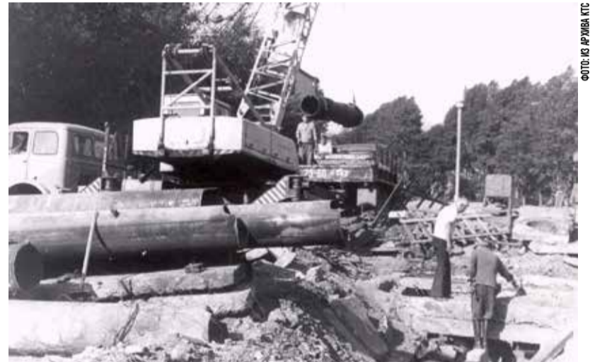
Строительство теплосети в Комсомольске
