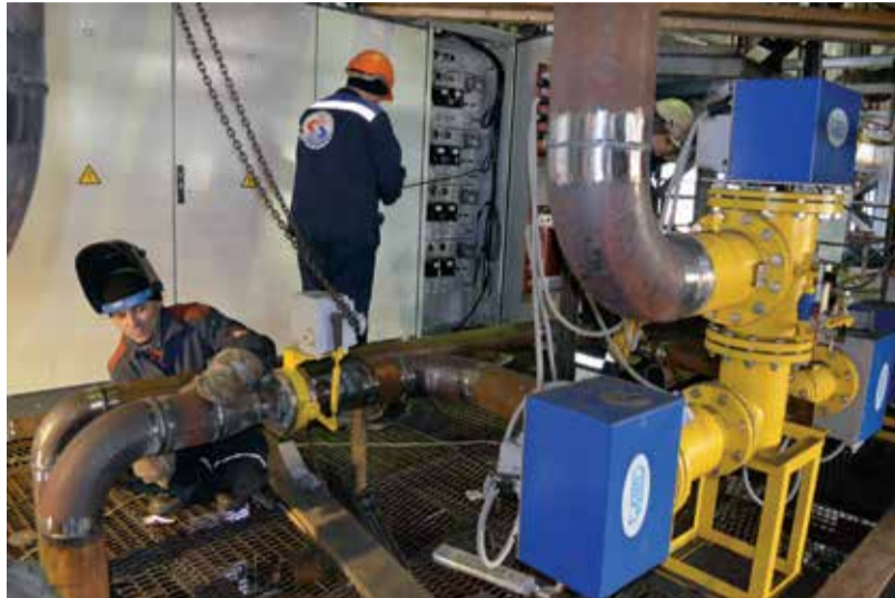
Идет монтаж газового оборудования
