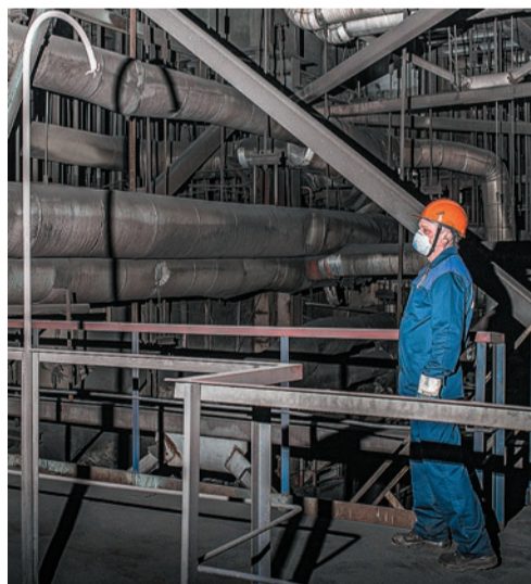
Ⓢ Визуальный осмотр оборудования
