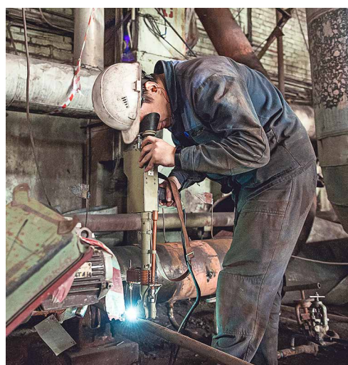
© Работы на объектах генерации и сетях идут строго по графику. Фото: пресс-служба АО «ДГК»
