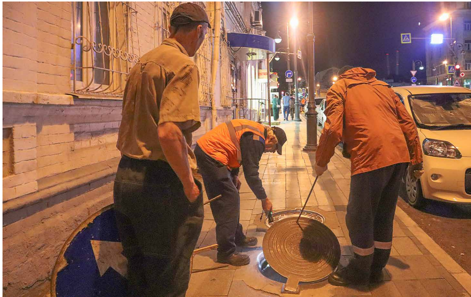
© Каждая тепловая камера на участке тщательно обследуется. Фото: Екатерина Сенько
