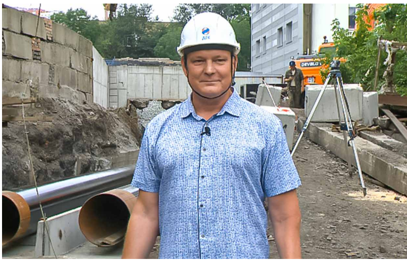
© Заместитель главного инженера ПТС Олег Безногов на участке проведения работ.
