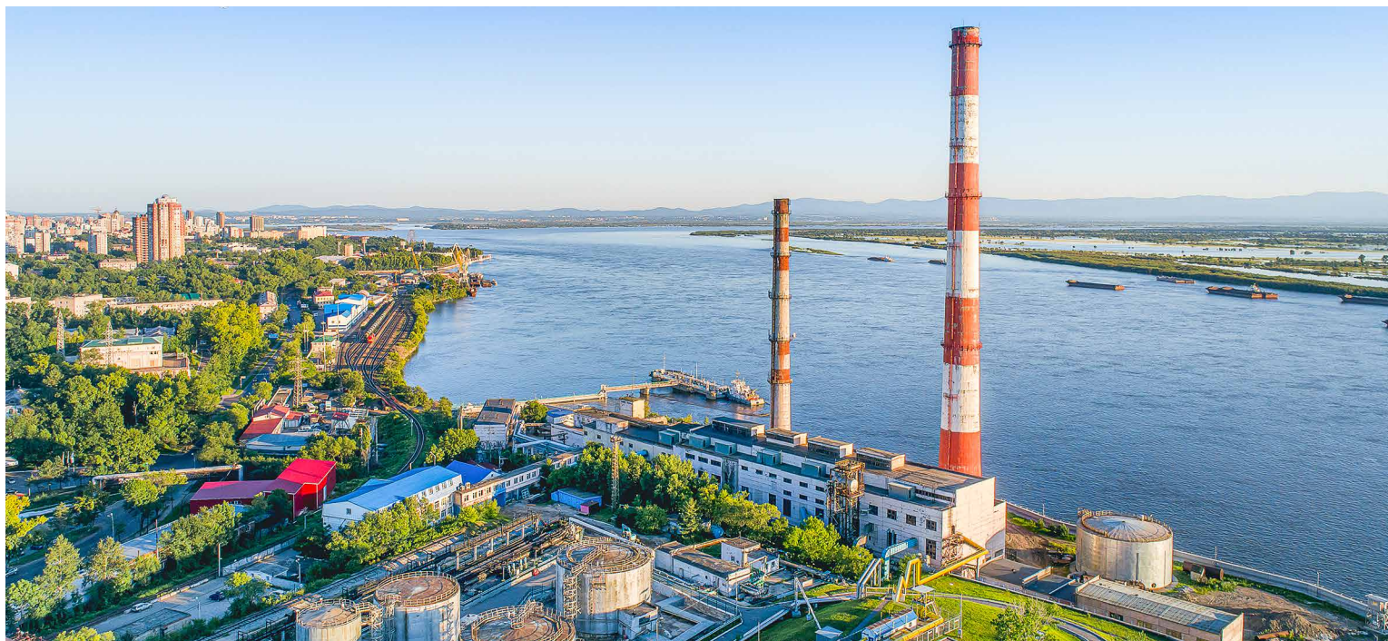
© На ХТЭЦ-2 ремонты ведутся параллельно с переводом котла № 3 на газовое топливо. Фото: пресс-служба АО «ДГК»
