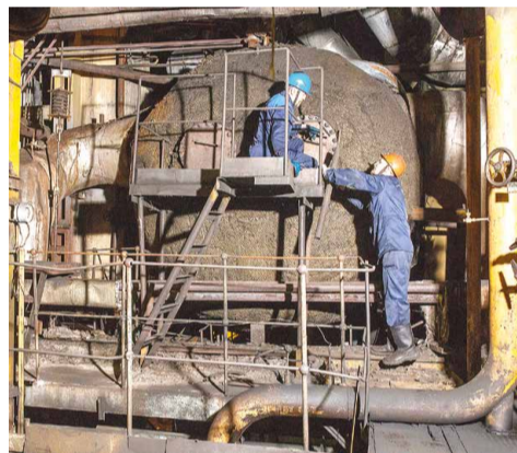
■ Проверка подогревателя сетевой воды
