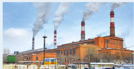
Восьмой по счету котлоагрегат Хабаровской ТЭЦ-1 переведен на газ
