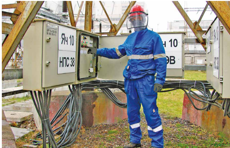
При выполнении работ контроль применения работниками спецодежды и средств защиты осуществляется постоянно
