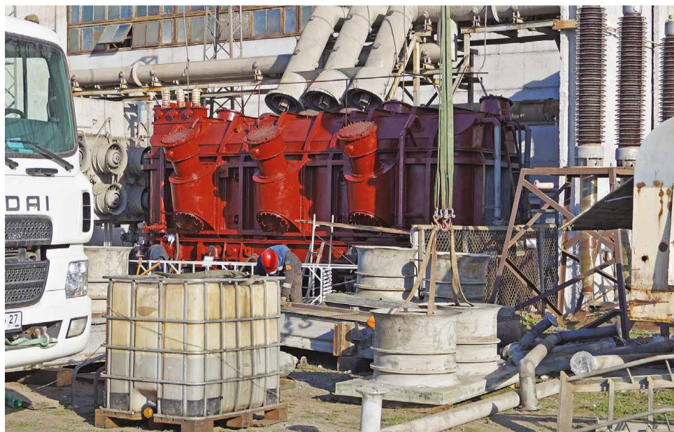
■ Ремонт автотрансформатора ЗАТ
