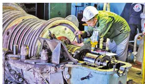
Идет замер уплотнительных колец на турбогенераторе № 1
