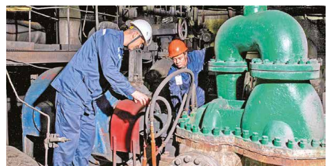
НГРЭС, ремонт сетевой установки
