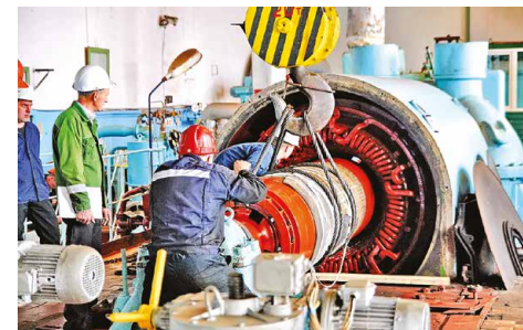
Идет установка ротора генератора № 1
