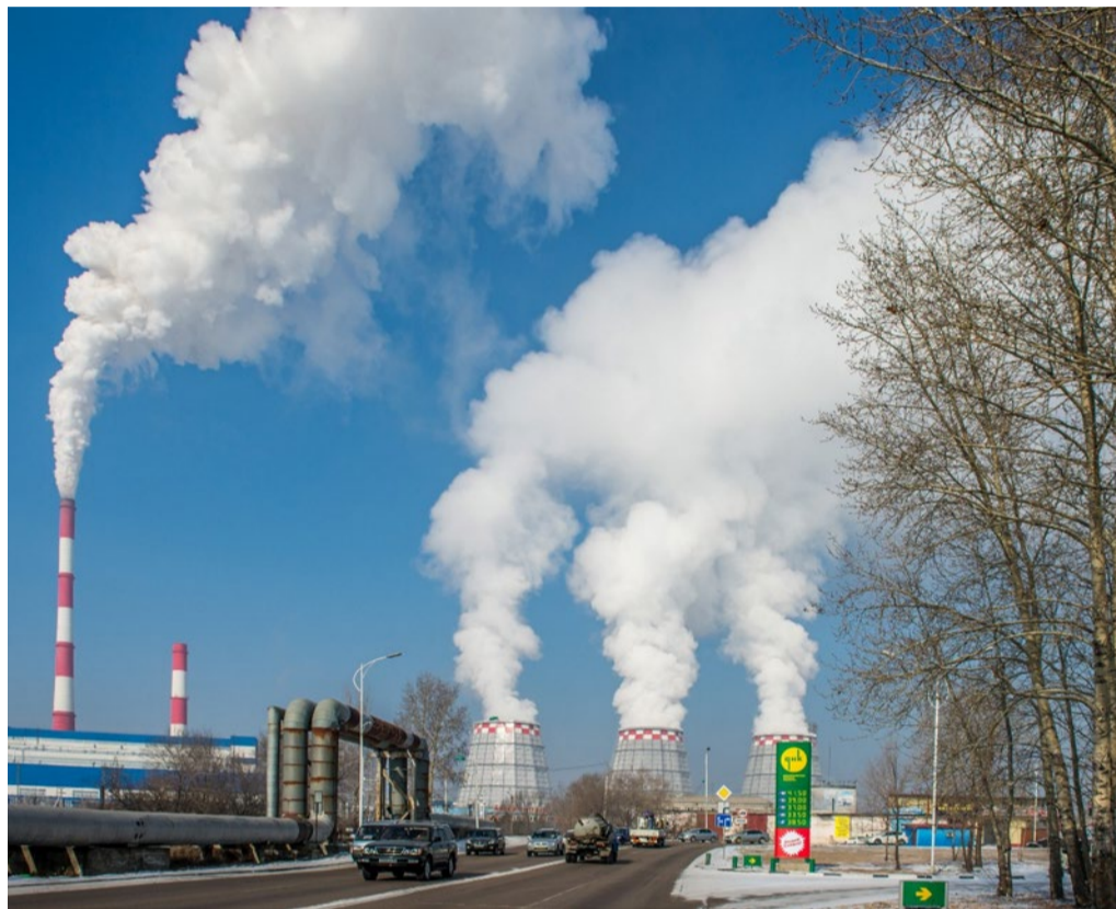
ТЭЦ обеспечивает теплом 85 % потребителей областного центра
