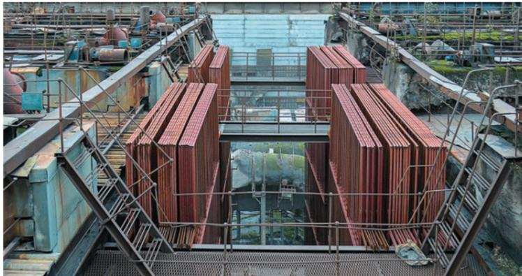
© Обновленное фильтрующее оборудование второго энергоблока позволит улавливать до 99,9% вредных веществ. Фото Марины Булдыгеровой
