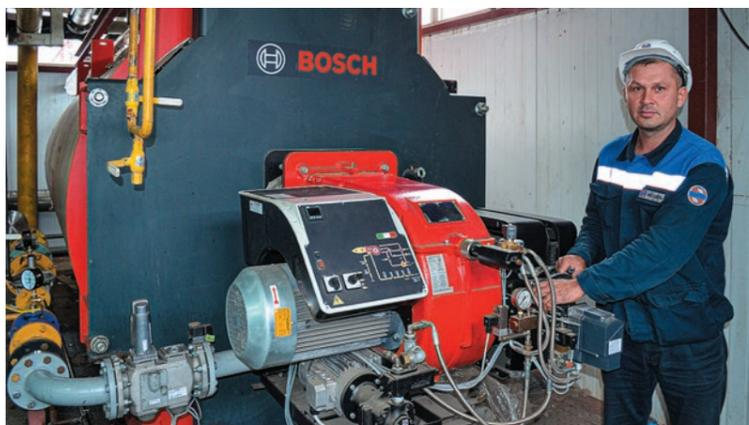
© Начальник котельной Руслан Хасанов проверяет подключение газовой горелки. Она комбинированная — работает как на природном газе, так и на дизельном топливе. Фото Марины Булдыгеровой
