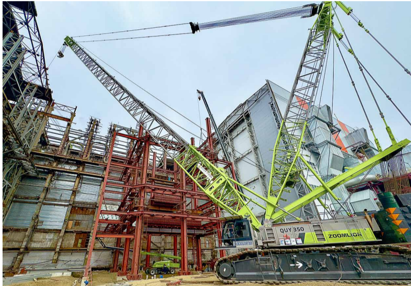
© Уже смонтировано 200 т металлоконструкций — это больше половины каркаса котла. Фото: Александра Зуева
