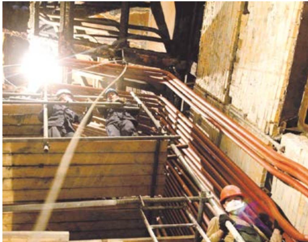
Капитальная замена экранов в котле № 8
