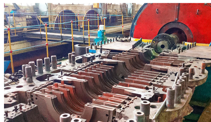
Ф. Контроль металла проточной части — один из видов работ, проведенных на турбине во время ремонта. Фото Дениса Холюкова
