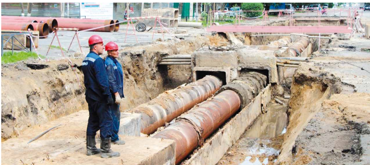
Ремонт самой старой тепломатриалы Благовещенска
