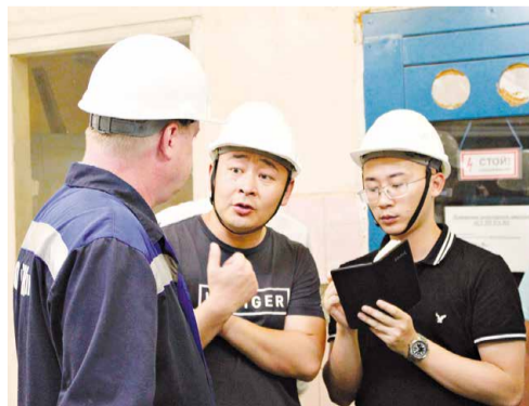
У теплового щита управления
