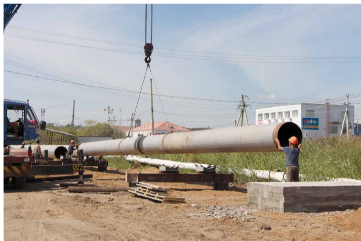
Монтажники смонтируют 596 м трубопроводов
