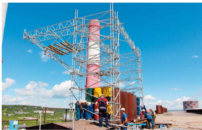
Сборка выносной консоли для подъема шумоглушителей
