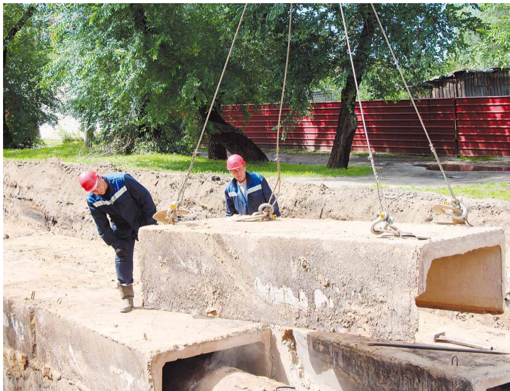
Демонтаж бетонных лотков тепломатриалы
