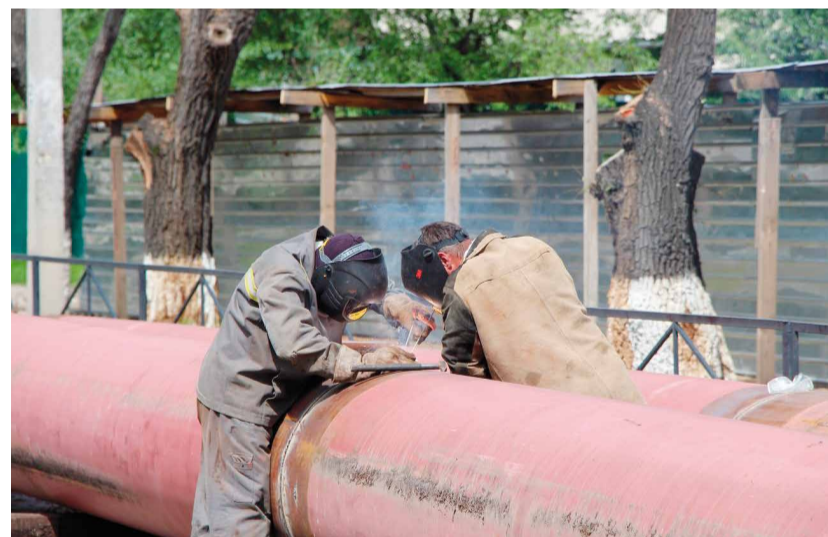
Сборка трубопровода в блоки
