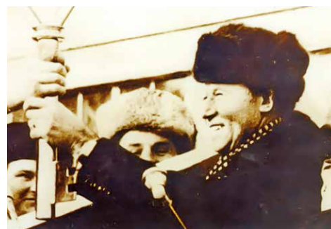
■ Директор строящейся Приморской ГРЭС Онищенко О.А. Пуск 1 энергоблока 15 января 1974 г.
