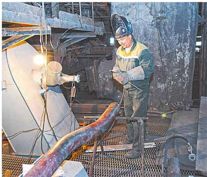
МОНТАЖ ГАЗОВОЙ ГОРЕЛКИ НА УГОЛЬНОМ КОТЛОАГРЕГАТЕ
