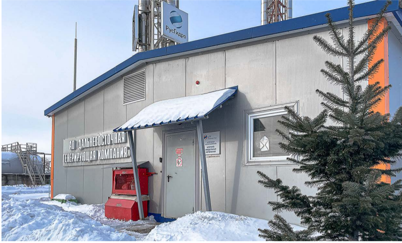
© Строительство котельных в отдельных случаях оказывается выгоднее прокладки тепломатриалов. Котельная «Волочаевская» в Хабаровском крае уже успешно функционирует, на очереди — аналогичные проекты в других городах присутствия. Фото: пресс-служба ДГК
