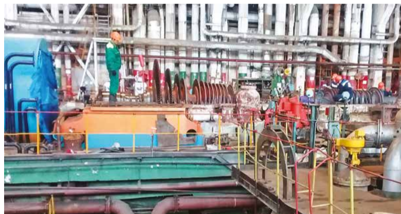
■ Ведутся работы на турбоагрегате № 2 Амурской ТЭЦ
