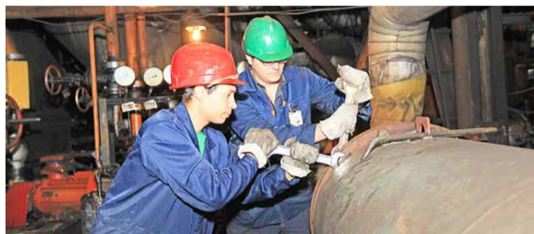
■ Ремонт вспомогательного оборудования НГРЭС
