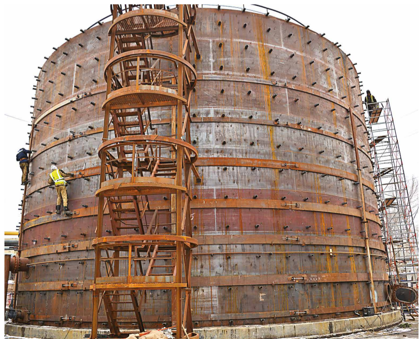
На объединенной котельной «Северная» завершается монтаж двух баков-аккумуляторов горячей воды
