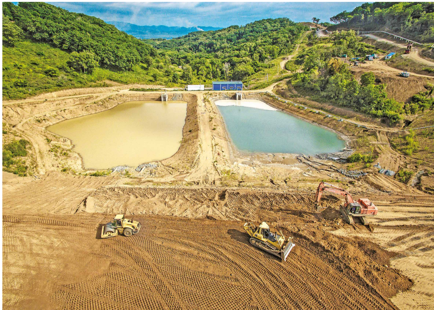
Работы по строительству золошлакоотвала «Зеленая балка» для Партизанской ГРЭС
