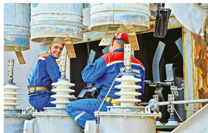
Специалисты электротехнической лаборатории выполняют измерения перед началом капитального ремонта трансформатора 2ВТ Благовещенской ТЭЦ
