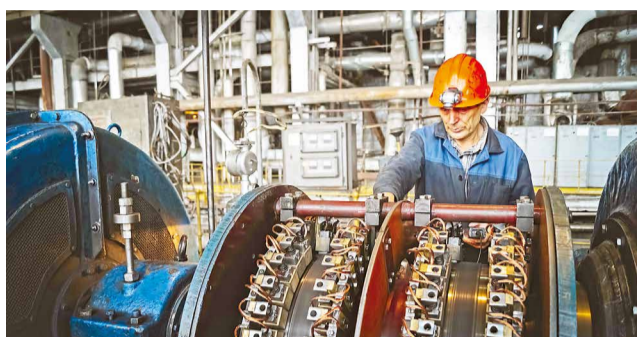
Ремонт генератора на Хабаровской ТЭЦ-1
