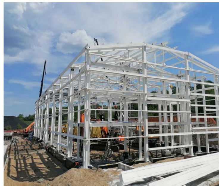
Каркас главного корпуса котельной уже покрыли антикоррозийной защитой. Фото из архива Майской ГРЭС
