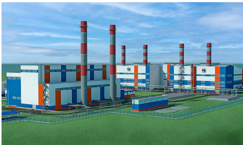
Пока новая электростанция только в проекте, но площадка для строительства уже готовится. Иллюстрация предоставлена пресс-службой ПАО «РусГидро»
