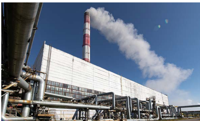
Дым из трубы Хабаровской ТЭЦ-3 после реконструкции котлов заметно побелет. Фото Вячеслава Лукьянова
