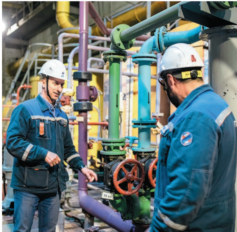
© Сергей Еремеев, начальник ЦВР, принимает выполненные работы по замене арматуры в помещении ХВО. Фото Романа Зарышнюка
