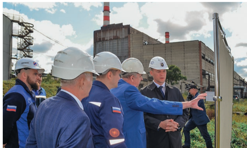
© Мечта и цель Владимира Ларикова — чтобы на всех электростанциях региона было самое современное оборудование. Фото из архива пресс-службы Хабаровской генерации
