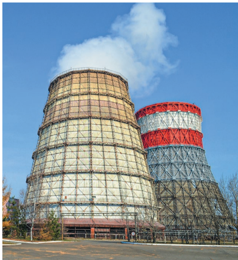
© На окрашивание в сигнальные цвета второй градирни Хабаровской ТЭЦ-3 ушло 14 тонн эпоксидной эмали. Фото Марины Будыгеровой
