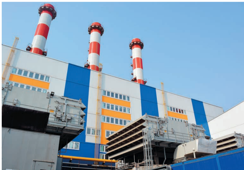
ТЭЦ «Восточная» — единственная станция, построенная во Владивостоке за последние 45 лет
