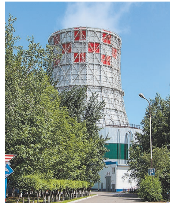
НА ВОЗВЕДЕНИЕ КАРКАСА НОВОЙ ГРАДИРНИ УШЛО БОЛЕЕ 500 ТОНН МЕТАЛЛОКОНСТРУКЦИЙ
