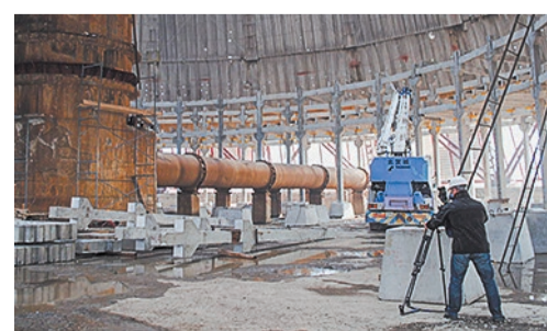
ВОЗВЕДЕНИЕ ГРАДИРНИ № 1 (1985 Г.). САМАЯ СТАРАЯ ИЗ ТРЕХ БАШЕН, ОНА БЫЛА СДАНА В ЭКСПЛУАТАЦИЮ 30 ЛЕТ НАЗАД ВМЕСТЕ С ПЕРВЫМ ЭНЕРГОБЛОКОМ
