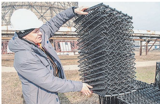
ГЛАВНЫЙ ИНЖЕНЕР ХТЭЦ-3 ВЛАДИМИР КУЗЕМА ДЕМОНСТРИРУЕТ ИННОВАЦИОННЫЕ ДЕТАЛИ, КОТОРЫЕ ИСПОЛЬЗОВАЛИСЬ ПРИ РЕКОНСТРУКЦИИ ГРАДИРНИ
