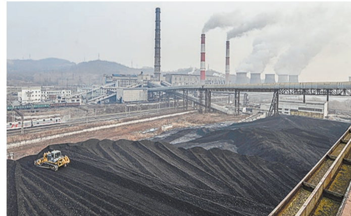
НА 1120 ТОНН СОКРАТИТСЯ ВЫБРОС ТВЕРДОЙ ПЫЛИ В АТМОСФЕРУ НА АРТЕМОВСКОЙ ТЭЦ БЛАГОДАРЯ УСОВЕРШЕНСТВОВАНИЮ ЗОЛОУЛОВИТЕЛЕЙ КОТЛОАГРЕГАТА
