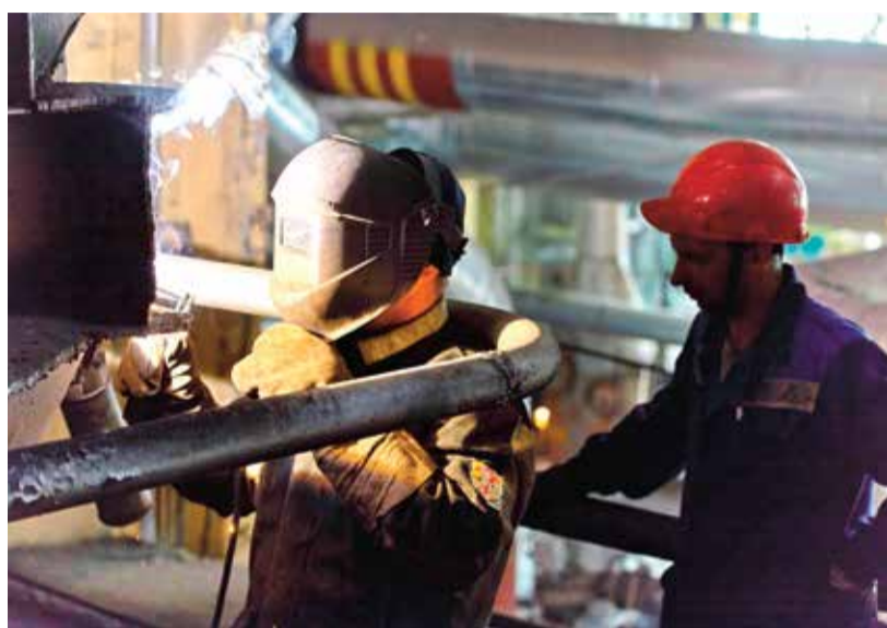
Ремонт котлоагрегата Райчихинской ГРЭС продлился 108 суток
