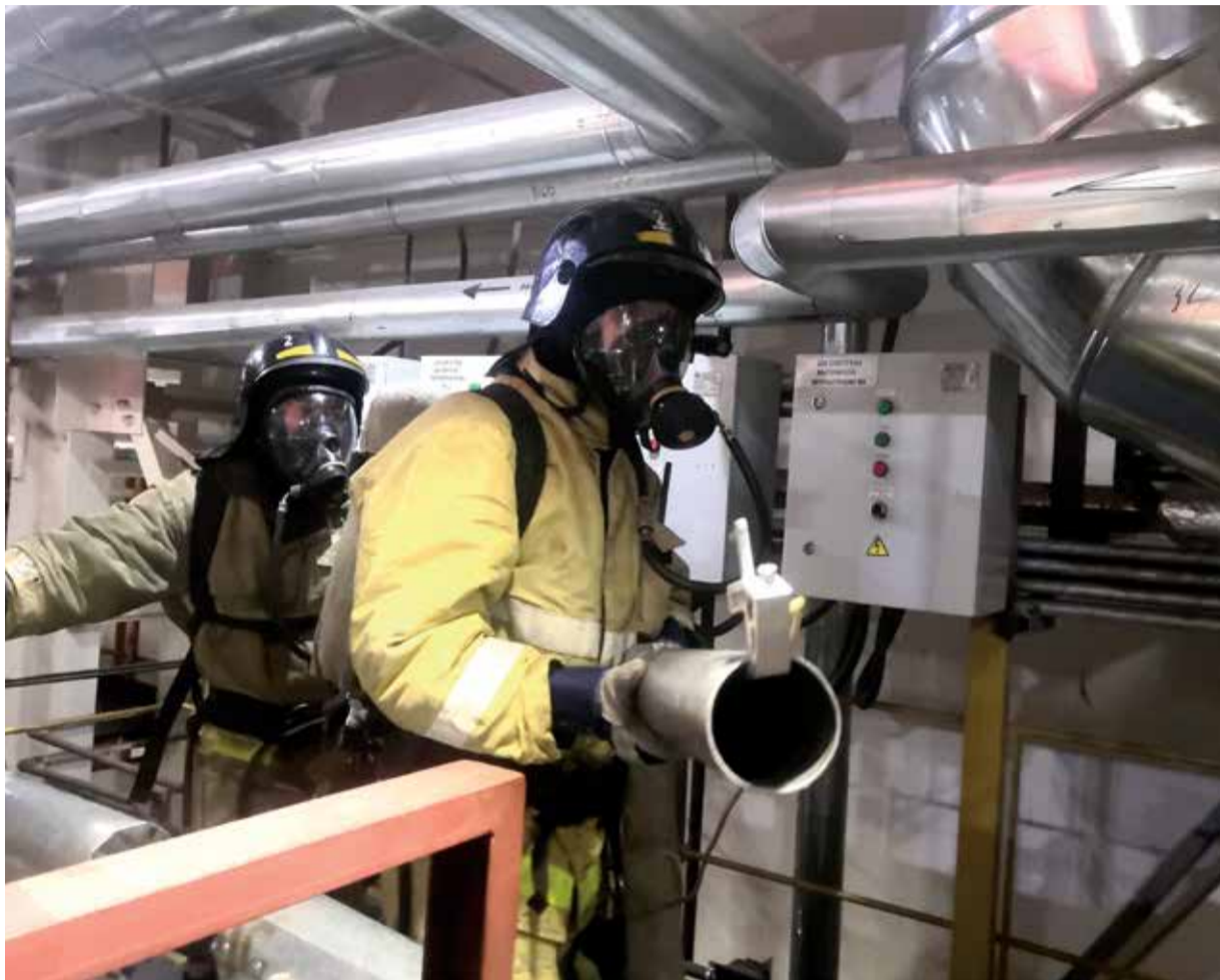
Важна каждая секунда, ведь для разрушения металлических конструкций станции требуется всего 15 минут огневого воздействия
