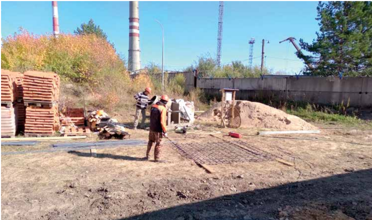
Энергетики Амурской ТЭЦ-1 приступили к строительству насосной станции осветленной воды
