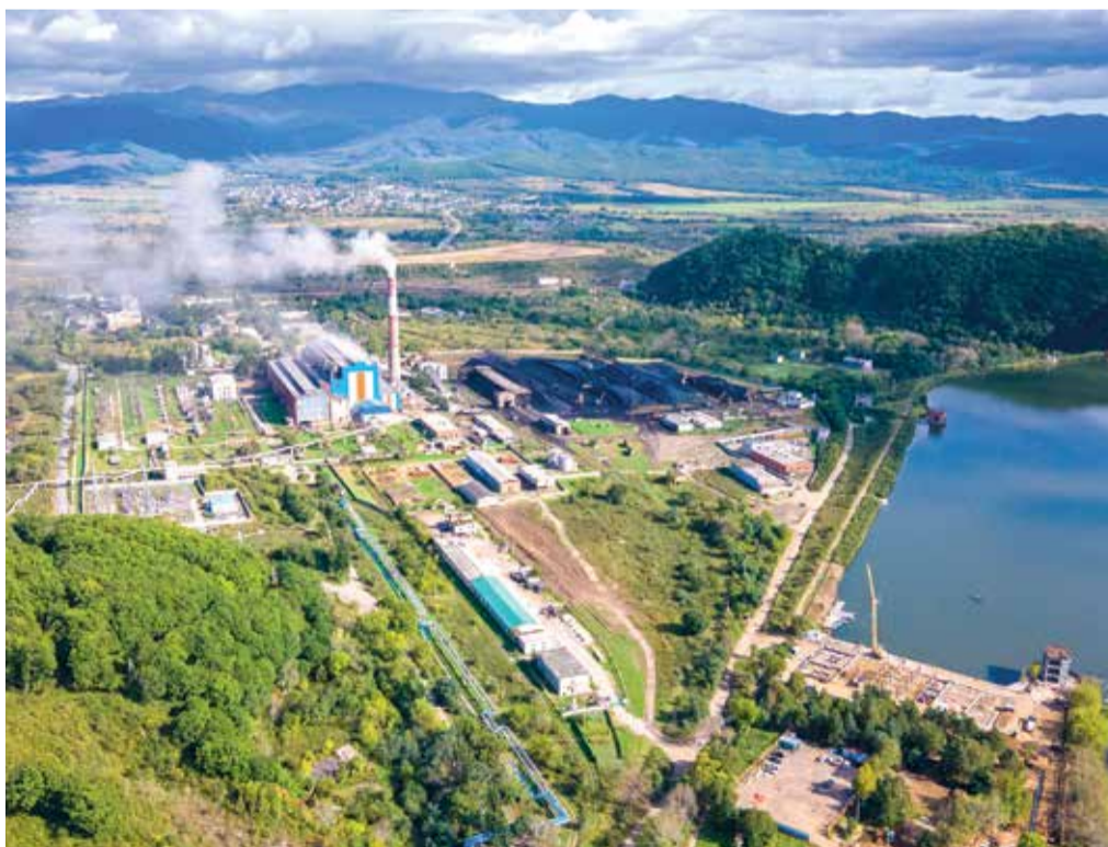
В рамках ремонтной программы на ПГРЭС заменен временный торец котельного отделения
