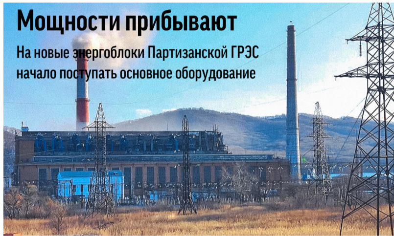
© Проект расширения Партизанской ГРЭС включает строительство двух энергоблоков общей мощностью 280 МВт. Фото: Олег Арнаут
