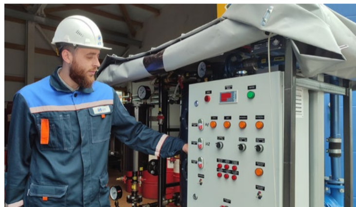
© Новая установка позволит и снизить выбросы, и экономить! Фото Александры Зуевой
