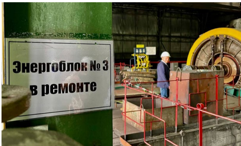
© На Хабаровской ТЭЦ-3 продолжается ремонт энергоблока № 3. Фото Семена Симоненко
