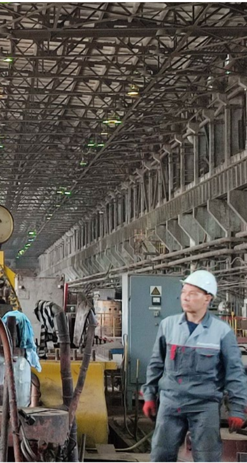
© На капитальный ремонт турбоагрегата № 5 Владивостокской ТЭЦ-2 уйдет 60 суток. Фото Александры Зуевой
