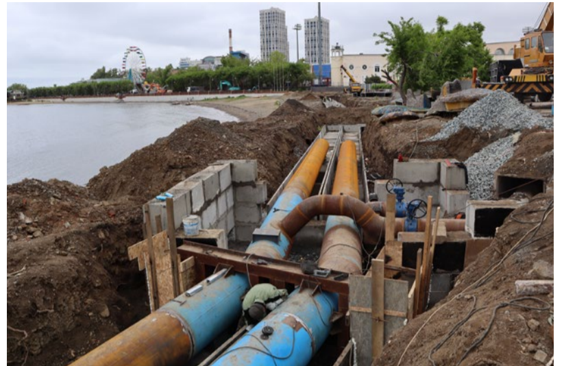
© Перекладки на двух участках в районе набережной Спортивной гавани во Владивостоке уже завершены. Фото Екатерины Сенько
