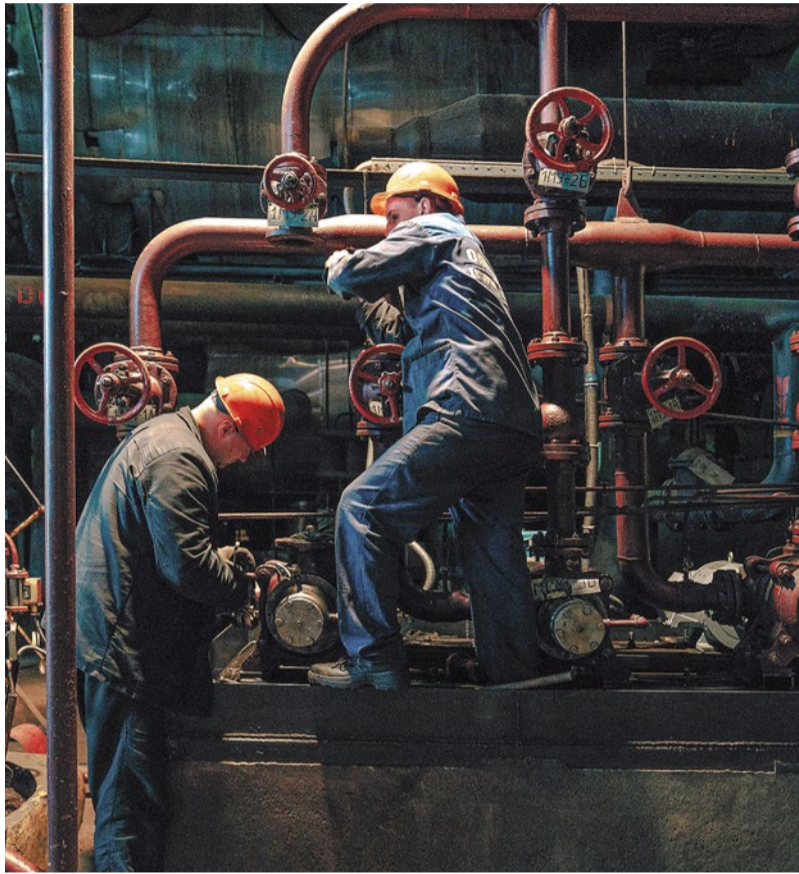
© После окончания отопительного сезона теплосетевые подразделения незамедлительно приступают к опрессовке и ремонту трубопроводов. Фото пресс-службы ДГК
