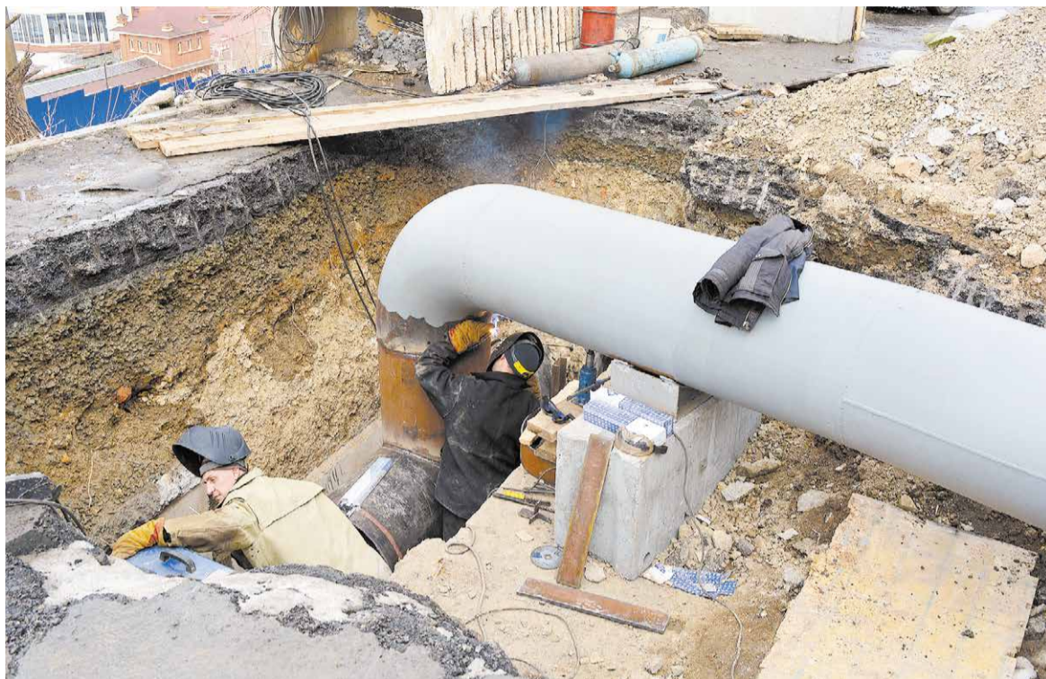
Энергетики Приморья заменят более 6 километров изношенных теплосетей
