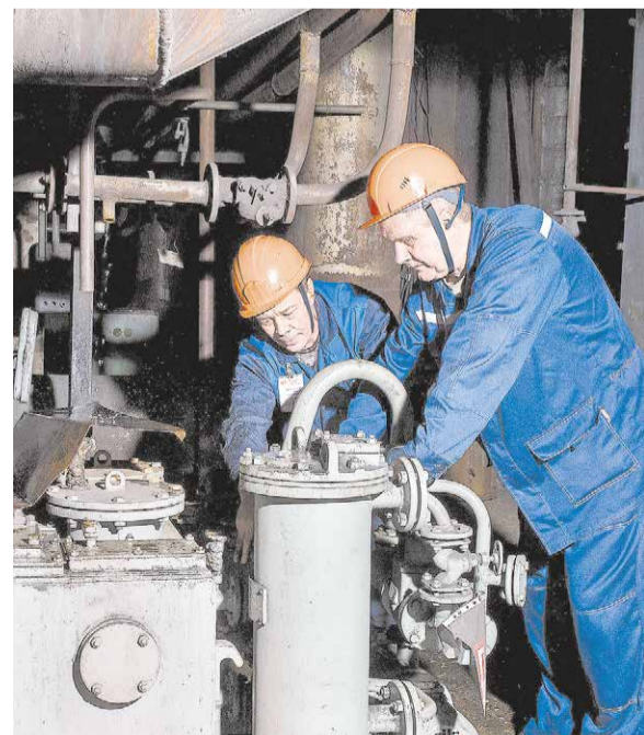
Подготовка рабочего места к ремонту маслостанции сетевого насоса
