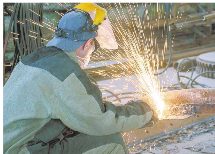
В 2018 году на Приморской ГРЭС будут отремонтированы 8 турбин и 11 энергетических котлов
