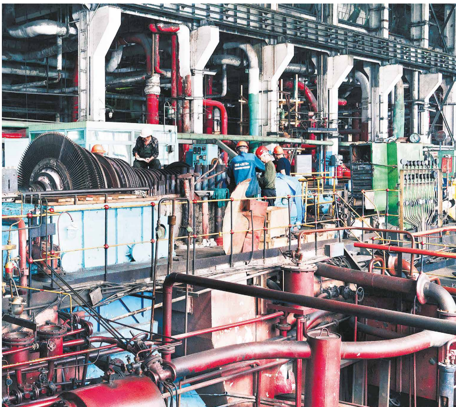
Комсомольская ТЭЦ-2. Здесь ремонтные работы также уже начались
