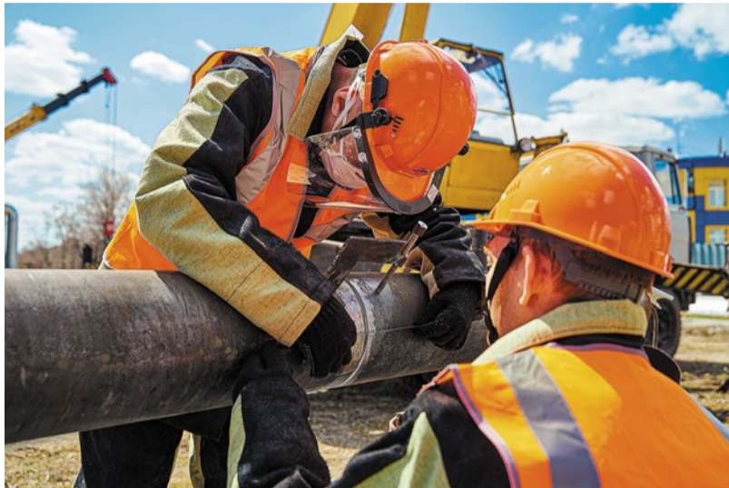
© После окончания отопительного сезона теплосетевые подразделения незамедлительно приступают к опрессовке и ремонту трубопроводов. Фото пресс-службы ДГК
