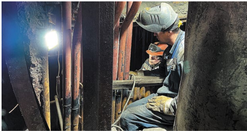
Работы ведутся на котельном оборудовании. Фото Семена Симоненко
