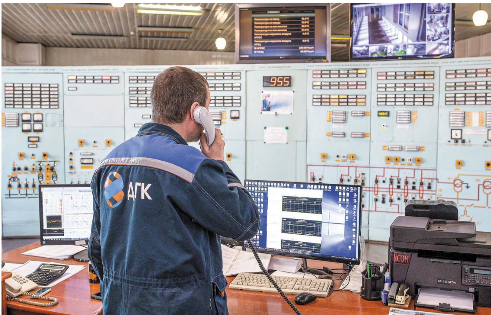
© Каждую минуту работу станции отслеживают и корректируют на главном щите управления. Фото пресс-службы НГРЭС
