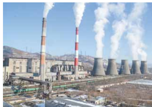
В рамках ремонтной программы преобразилась и дымовая труба №2 высотой 120 метров
