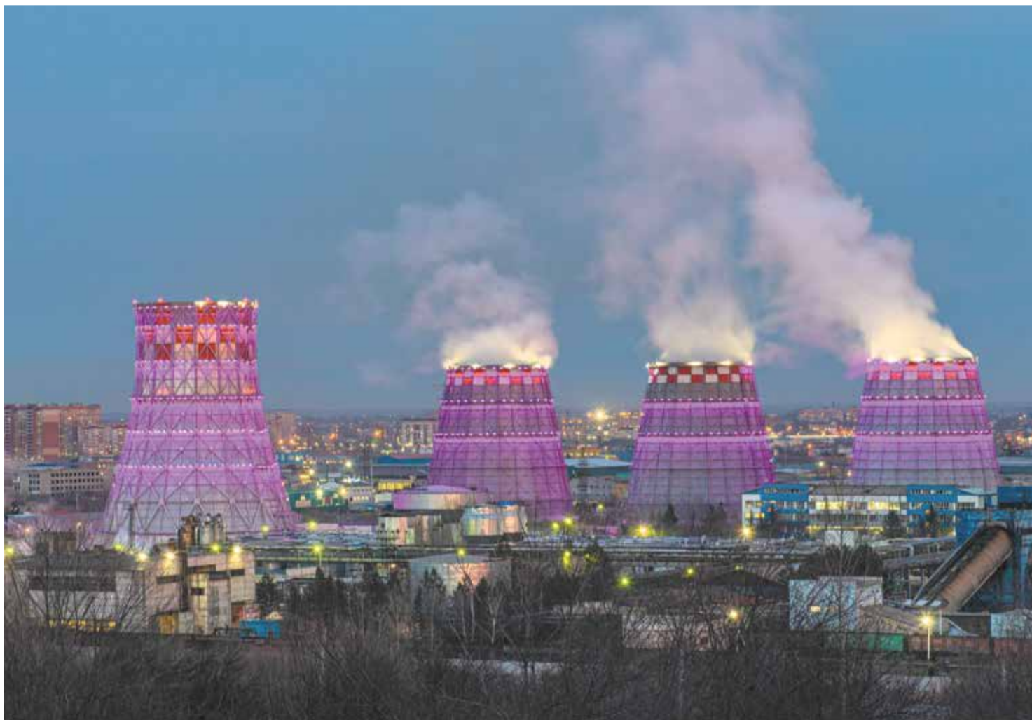
Уникальная подцветка установлена на градирнях Благовещенской ТЭЦ
