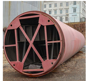
© В этом году Приморские тепловые сети выполняют монтаж аккумуляторного бака, в следующем — изоляцию и автоматику.
