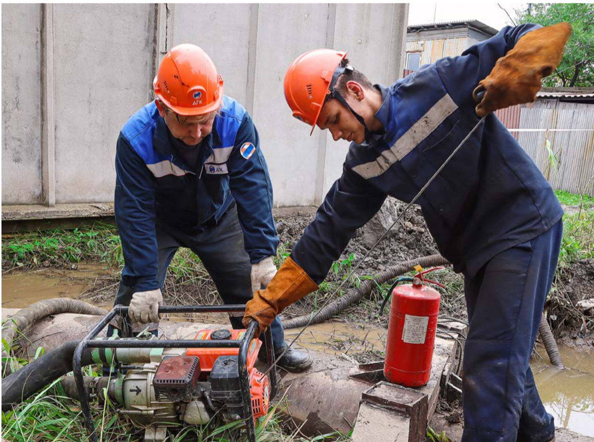
© На этом участке трассы самое сложное — не ремонт, а подготовка к нему. Специалисты ПТС откачивают грунтовые воды. Фото: Екатерина Сенько
