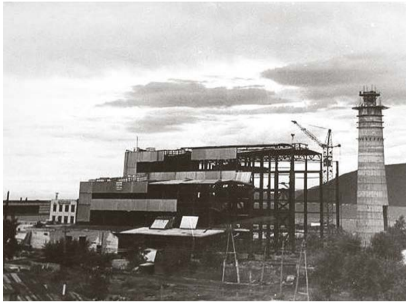
© Возведение первой очереди Николаевской ТЭЦ. Фото из архива ДГК
