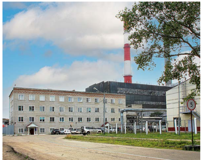
© Николаевская ТЭЦ сейчас — надежный фундамент, на котором строится энергетическое благополучие региона. Фото из архива ДГК
