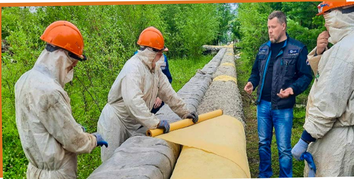
© Студенты стройотряда выполняют теплоизоляцию на магистральных теплосетях в Нерюнгри. Фото: пресс-служба ДГК
