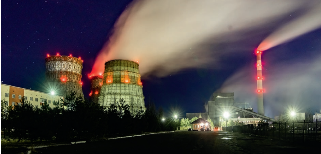
© На дымовой трубе ХТЭЦ-3 в 2022-м установят автоматизированную систему учета выбросов. Фото Вячеслава Лукьянова
