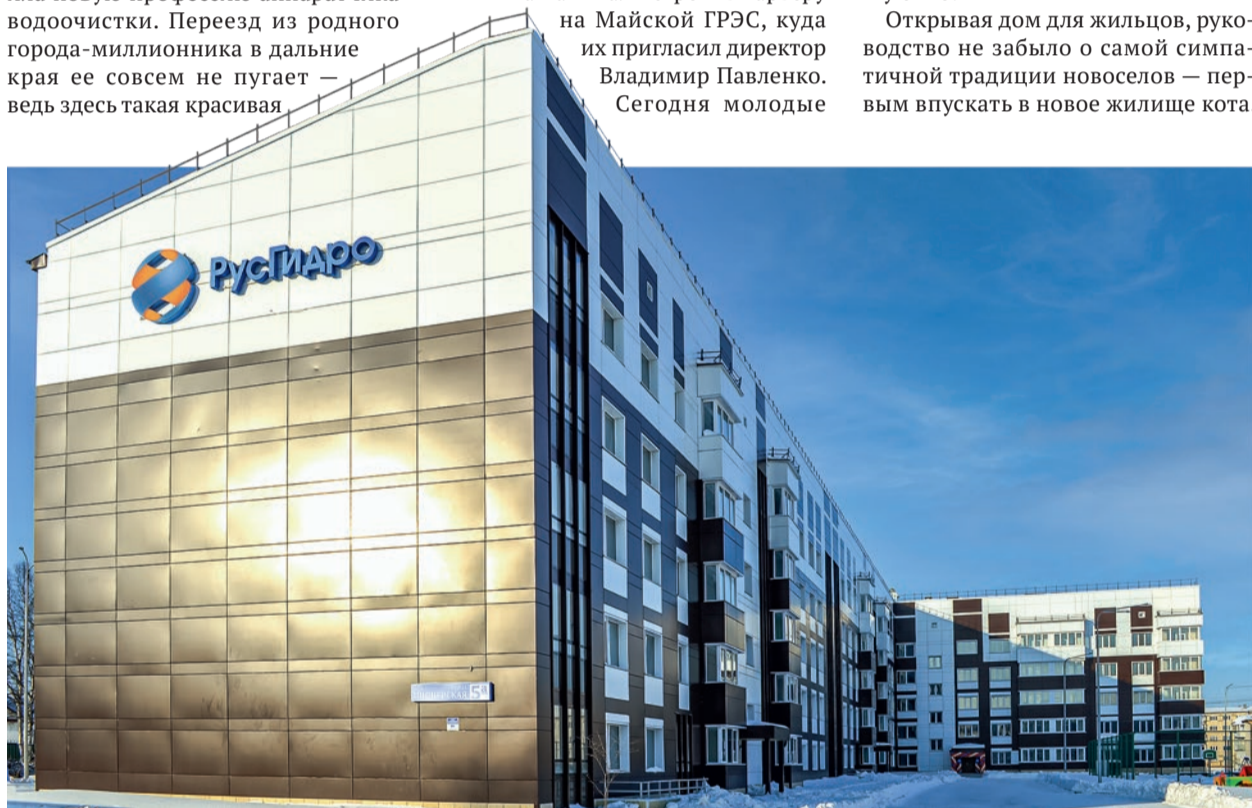
© Вид на дом для работников Совгаванской ТЭЦ. Фото Марины Булдыгеровой
