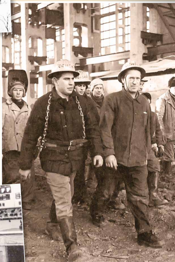
Бригада монтажников на строительстве второй очереди ТЭЦ рабочего поселка Амурск (1965 год)
