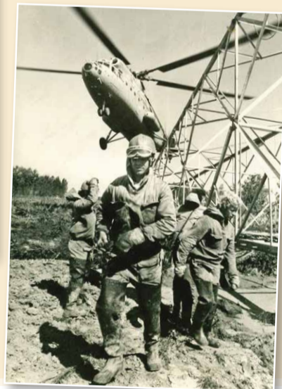
Монтаж опоры на строительстве ЛЭП-500 Зейская ГЭС – Хабаровск (1980-е годы)
