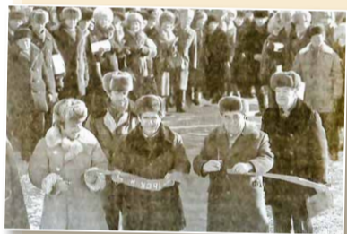
Первый секретарь Хабаровского крайкома КПСС А.К. Черный и первый секретарь Комсомольского горкома КПСС В.М. Крысин перерезают праздничную ленту на торжественном пуске ЛЭП-500 Хабаровск – Комсомольск-на-Амуре (Комсомольск-на-Амуре, март 1985 годы)
