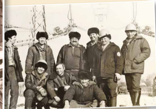
Ремонт провода на переходе ВЛ-220 кВ через реку Амур (март 1989 года)
