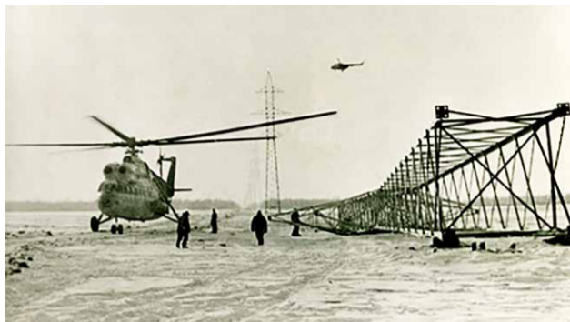
■ Установка опор линий электропередачи ЛЭП-220 Хабаровск — Комсомольск-на-Амуре (осень 1981 года)
