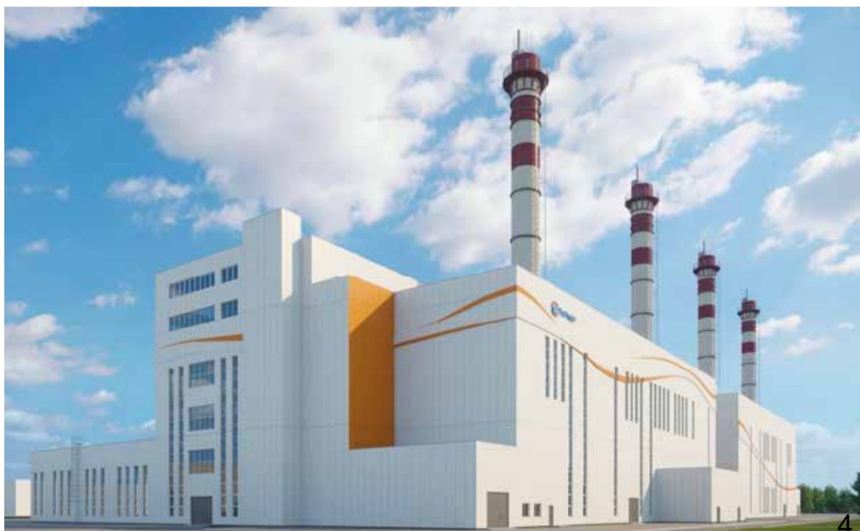
На месте действующей ТЭЦ будет новая, современная электростанция
