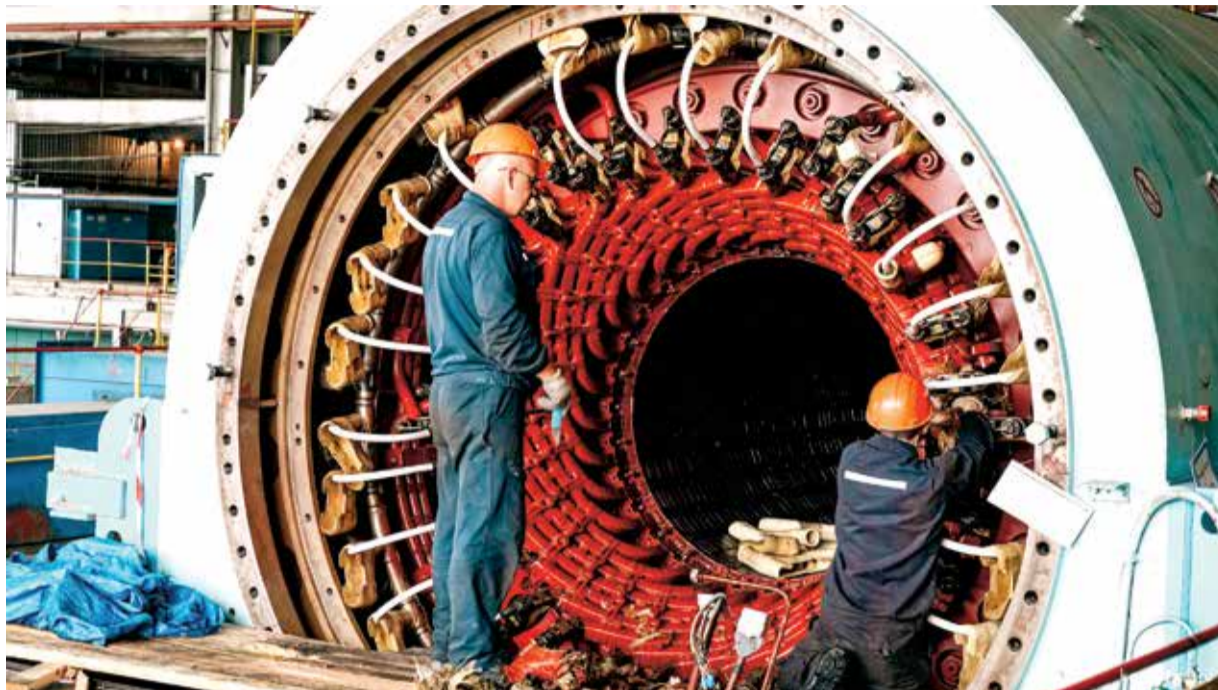
Ремонтный маховик на станциях ДГК начинает раскручиваться.
