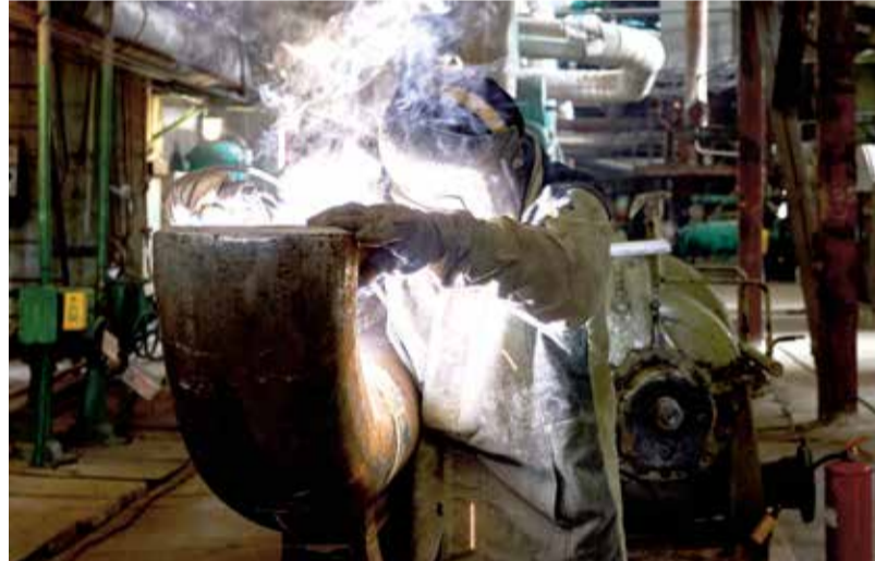
Рабочие будни энергетиков.
