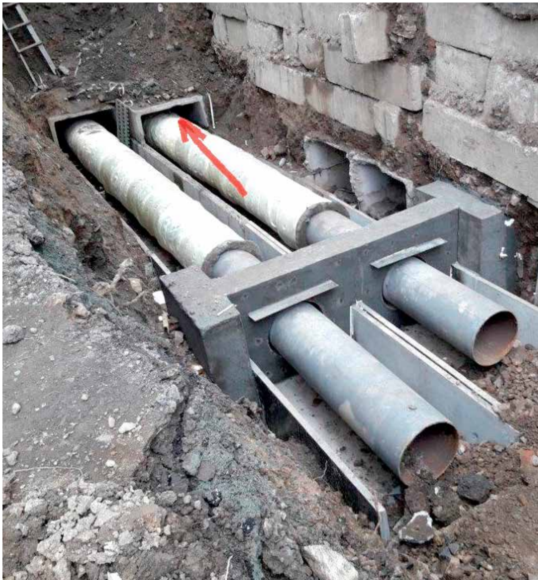
Стрелка указывает место обнаружения воровской «врезки», примерно в 25 см от края лотка.
