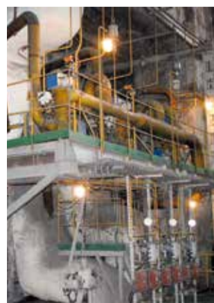
Один из уже газифицированных котлоагрегатов Хабаровской ТЭЦ-1
