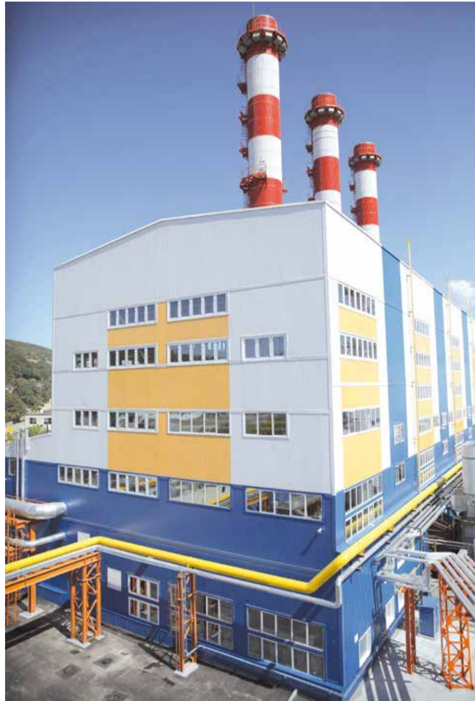
Общий вид главного корпуса ТЭЦ «Восточная»
