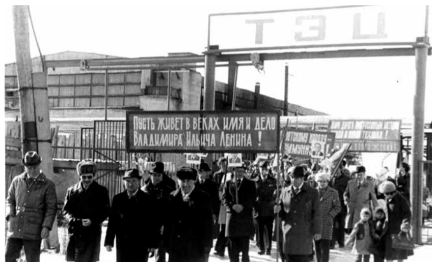
Николаевская ТЭЦ, 1981 г. Праздничная демонстрация. Впереди колонны – руководство станции
