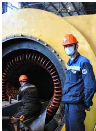
Машинист паровой турбины Хабаровской ТЭЦ-1 Денис Гельцер проверяет свое рабочее место в ходе ремонта
