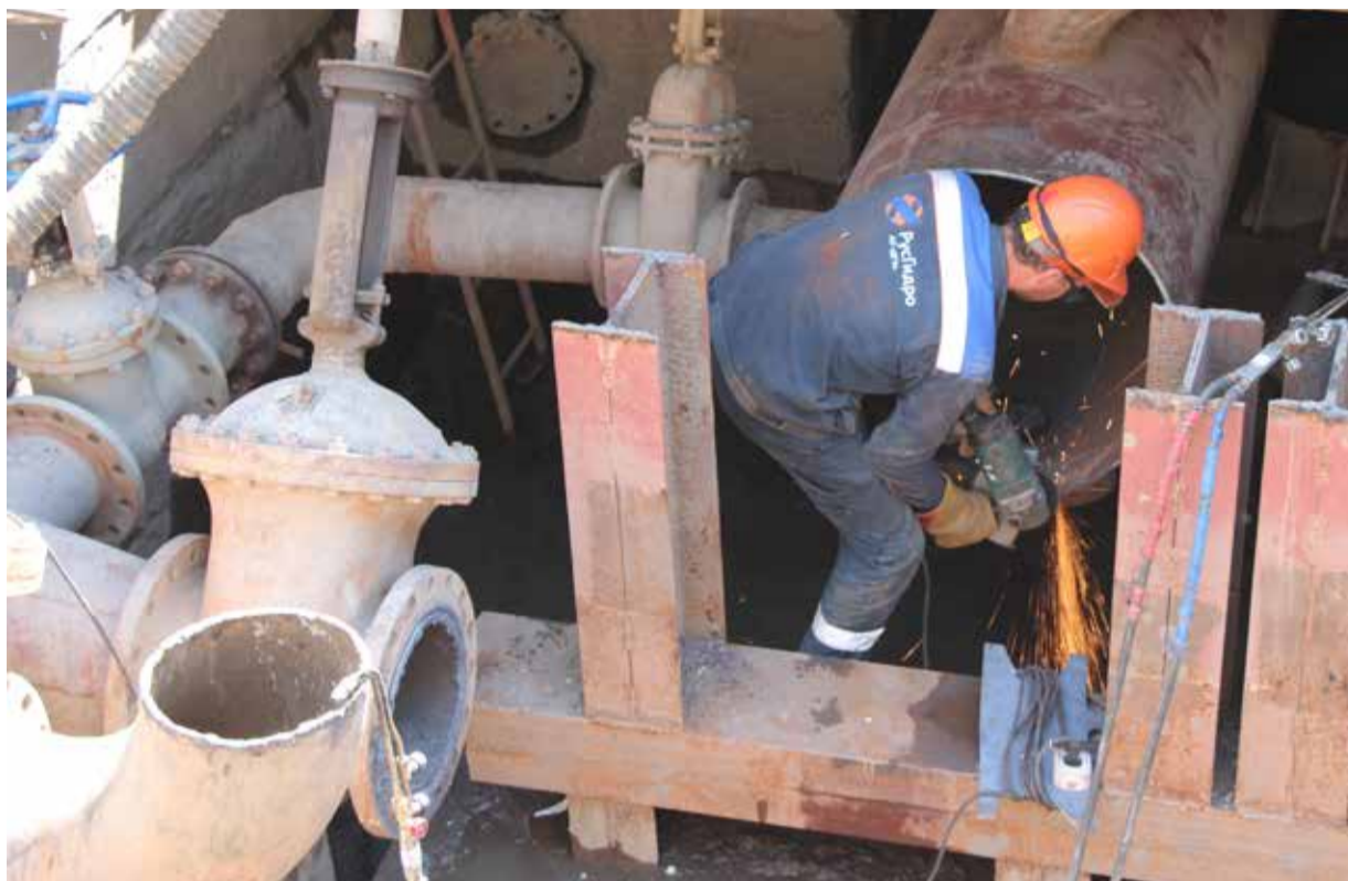
Торцы трубы обрабатывают для лучшей стыковки. На фото слесарь Сергей Лосев
