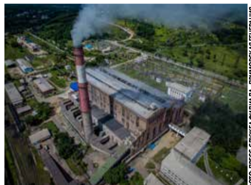
Бригады «ХРМК» совместно с персоналом ПГРЭС приступили к работам на турбоагрегате ст. №1
