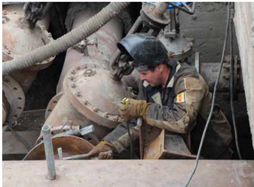
Электрогазосварщик Марат Ахметов соединяет новый фрагмент трубы с теплотрассой
