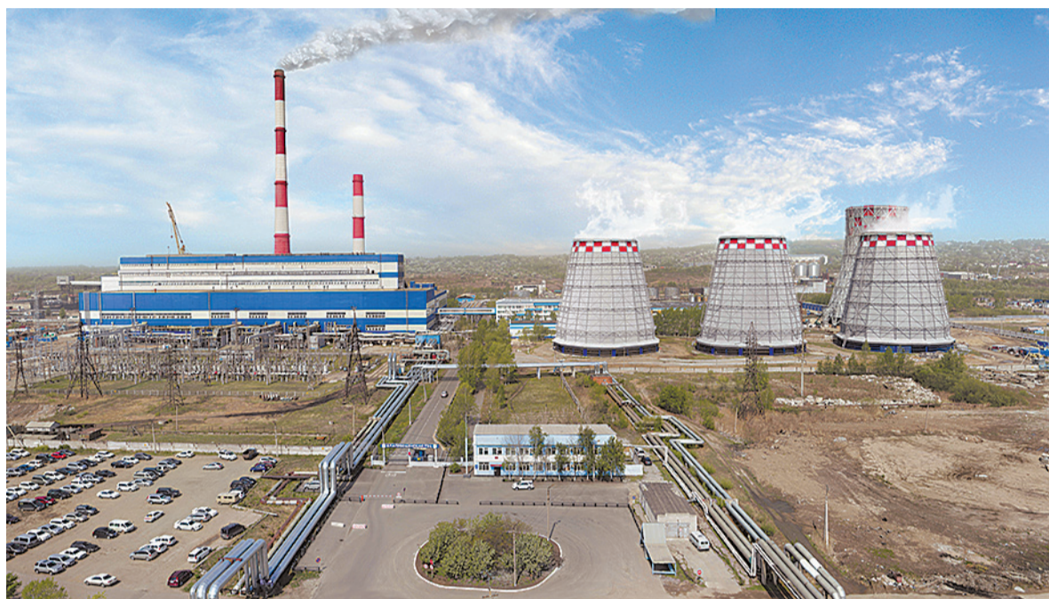
БЛАГОВЕЩЕНСКАЯ ТЭЦ ЯВЛЯЕТСЯ ИСТОЧНИКОМ ТЕПЛОВОЙ ЭНЕРГИИ ДЛЯ ЦЕНТРАЛЬНОГО, СЕВЕРНОГО И ЗАПАДНОГО РАЙОНОВ БЛАГОВЕЩЕНСКА И ОБЕСПЕЧИВАЕТ ТЕПЛОМ БОЛЕЕ 80% ОБЪЕКТОВ ГОРОДА
