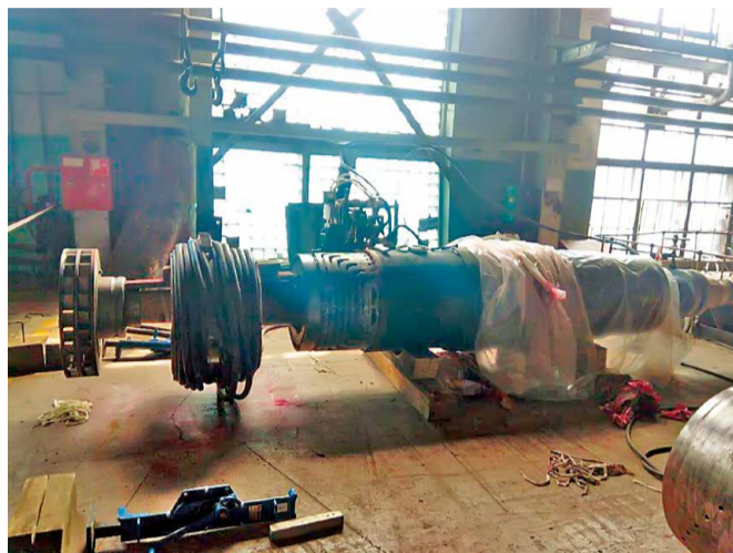
Ремонт турбогенератора на Райчихинской ГРЭС
