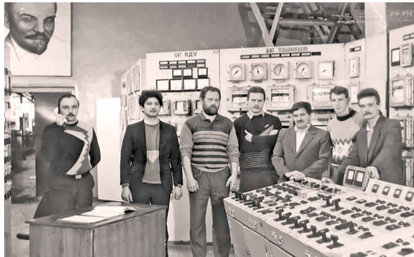
Главный щит, 1989 год
