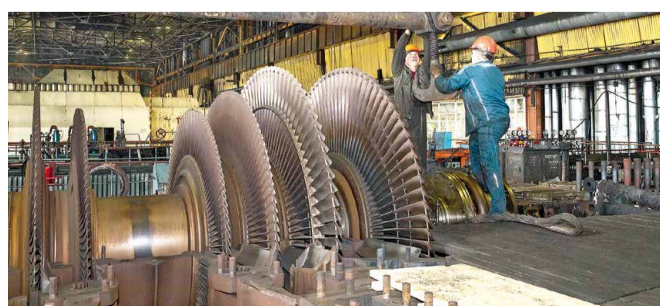
Ремонт энергоблока ст. № 1
