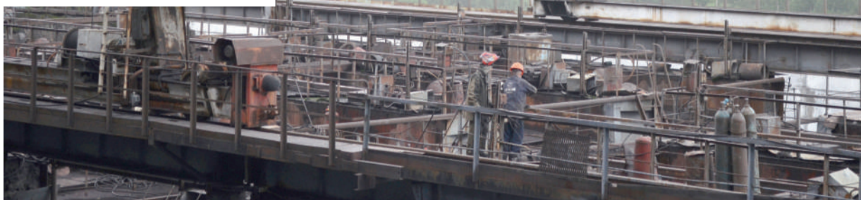
Замена старых полей электрофильтров позволит значительно сократить вредные выбросы в атмосферу
