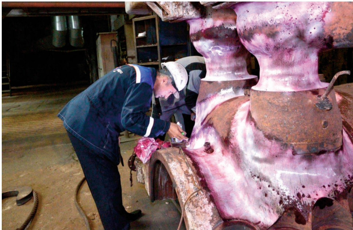
Проведение капиллярной дефектоскопии крышки цилиндра высокого давления ТГ-1
