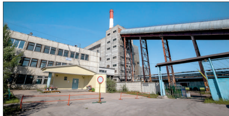
Нерюнградская водогрейная котельная
