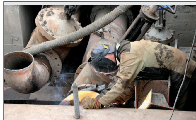
Реконструкция тепломагистрали Тепличного комбината длилась в течение 7 лет
