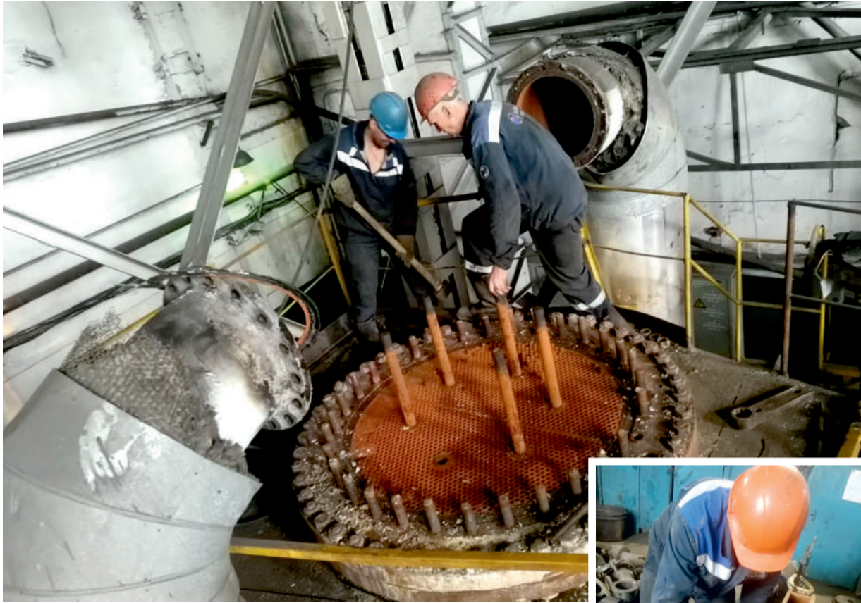
Ремонтные мероприятия на БТЭЦ повысят надежность работы оборудования
