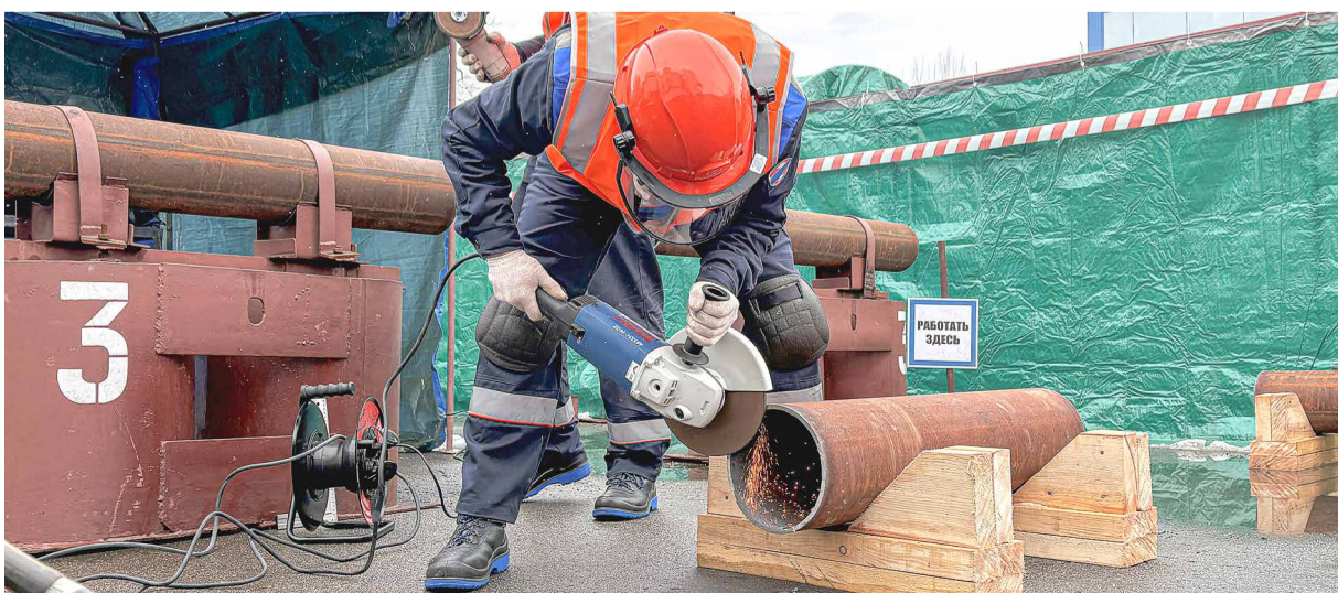
© Выполнение заданий на сварочном полигоне. Фото: пресс-служба АО «ДГК»
