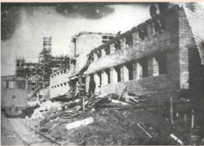
Строительство Майской ГРЭС
