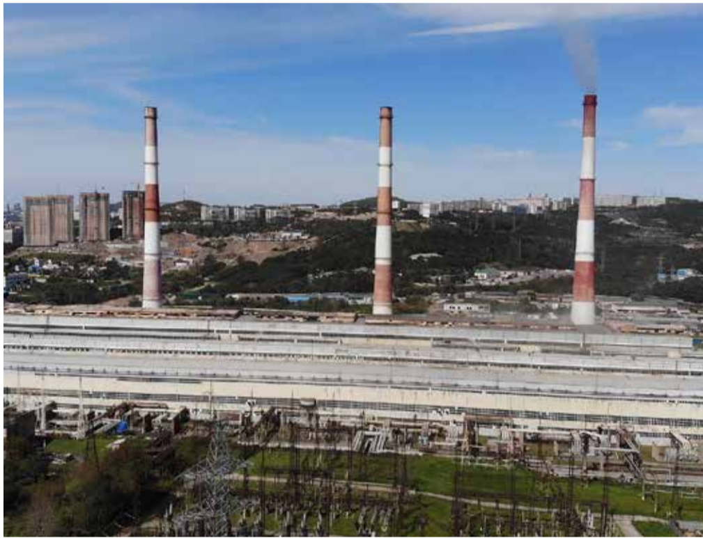
Установленная электрическая мощность станции – 497 МВт, тепловая – 1051 Гкал/ч
