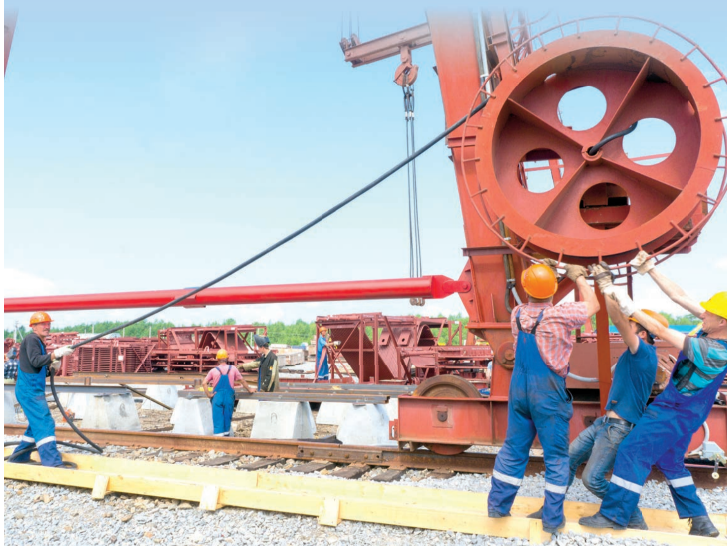
Пусконаладка козловой крана на строительстве ТЭЦ в г. Советская Гавань
