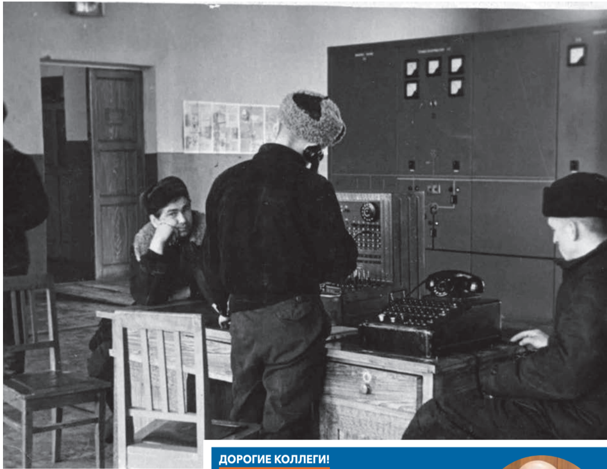
Подстанция Центральная. 1959 год
