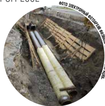
Специалисты подрядной организации демонтажируют тепломагистраль
