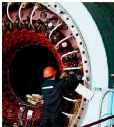
На станциях компании кипят ремонтные работы.
