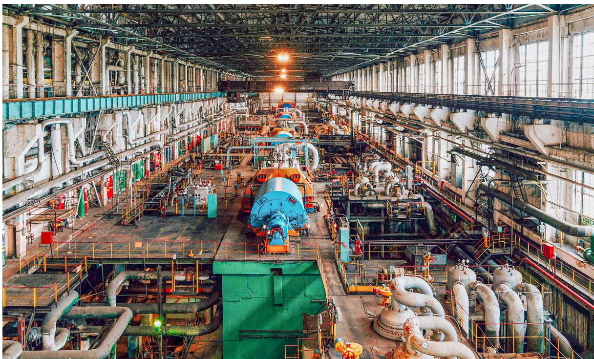
© На Амурской ТЭЦ продолжают масштабные ремонты турбин, котельного и трансформаторного оборудования. Фото: пресс-служба АО «ДГК»
