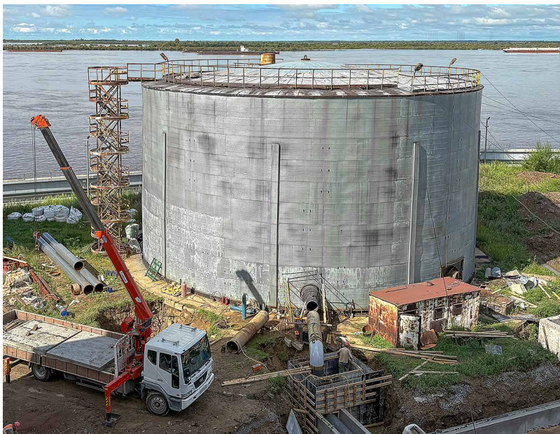
© На ХТЭЦ-2 модернизировали бак запаса воды вместимостью 5000 м 3 . Фото: Семен Симоненко
