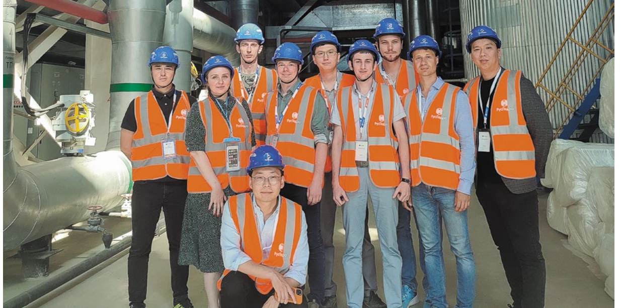
© ТЭЦ «Восточная» впечатлила молодых энергетиков современным оснащением. Фото: Александра Зуева
