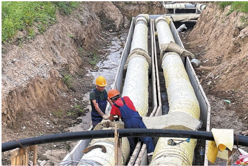
© Работы на участке тепломагистрали ТМ-17 на улице Панфиловцев выполнены на 90 % (по состоянию на начало сентября). Фото: Семен Симоненко
