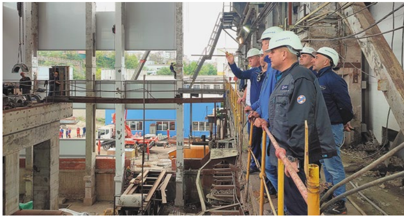
© Руководство РусГидро оценило ход работ по модернизации Владивостокской ТЭЦ-2.
