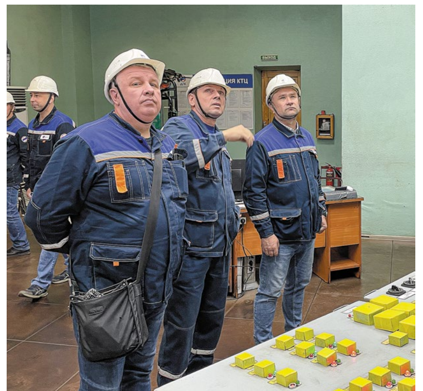
© Осмотр блочного щита управления Нерюнградской ГРЭС. Фото: Анна Неустроева
