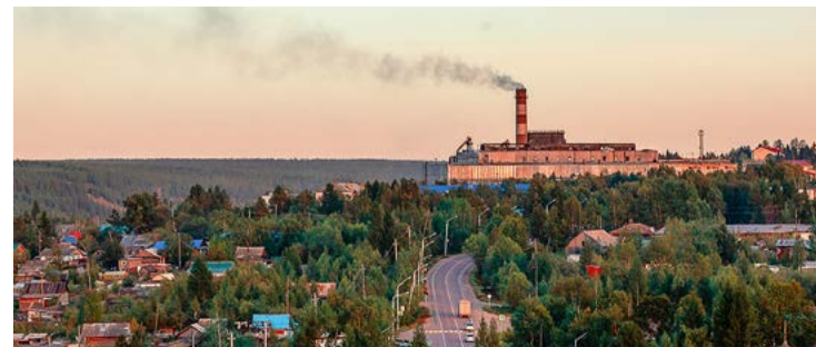
© На Чульманской ТЭЦ в 2021 году заменили около 200 дефектных участков трубопроводов. Фото Романа Зарышнюка
