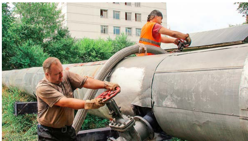
© Работники подключают к тепловой сети специальные шланги. Фото Маргариты Васюкевич
