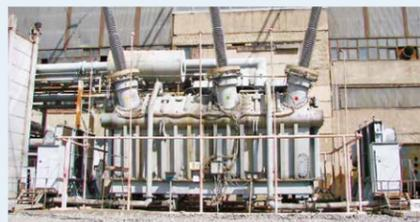
ЛутЭК собственными силами выполнил замену вводов 500 кВ трансформатора энергоблока № 9 Приморской ГРЭС
