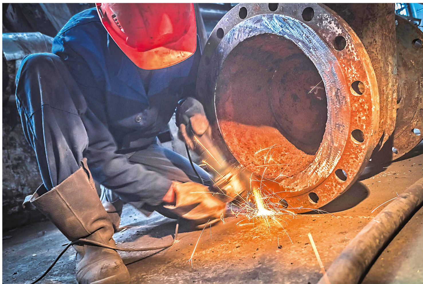
Ремонтные работы на Биробиджанской ТЭЦ
